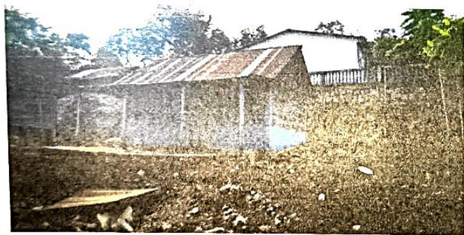
SE NECESITA TERMINAR CON BLOCK LA PARED DE LA COCINA
