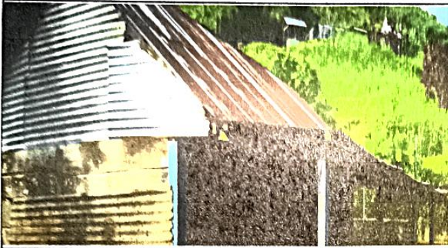
Foto 1: Sustrucion de cubierto de lamina de la cocina de 10.00 mts x 7.00 mts
